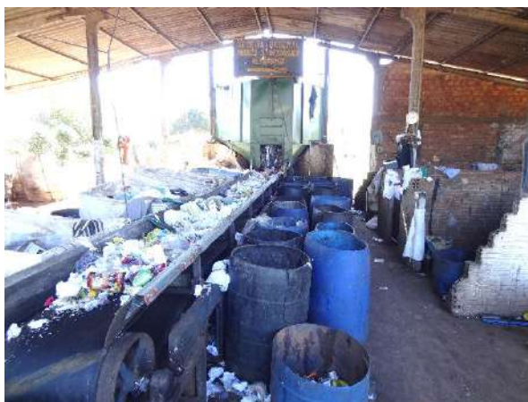
Figura 20 – UTR instalada no município de Mundo Novo/MS.
