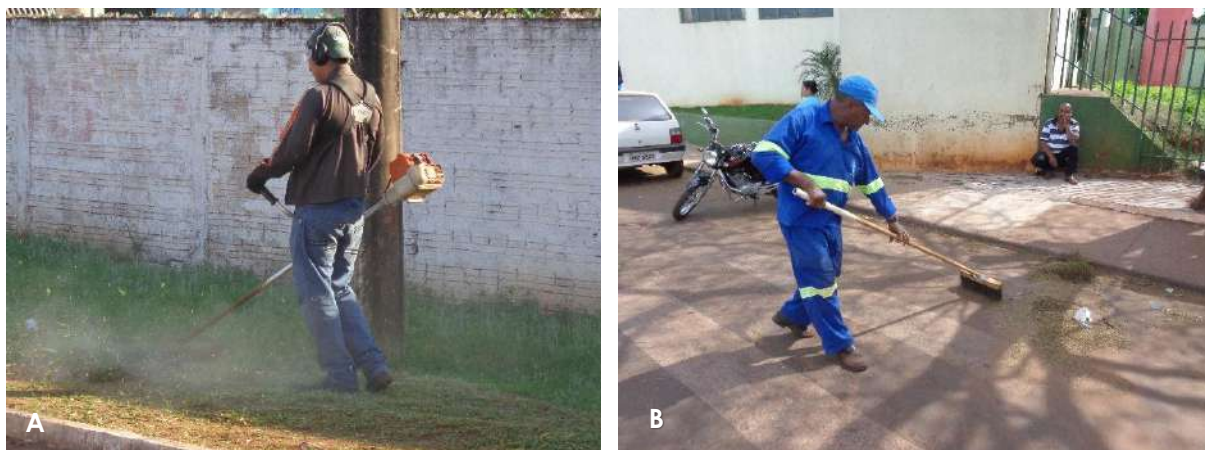
Figura 30 – Serviço de varrição, capina e roçada em Coronel Sapucaia (A) e Itaquiraí (B). Fonte: Deméter Engenharia Ltda., 2014.
