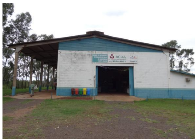
Figura 54 – Central de Recebimento de embalagens vazias de agrotóxico existente em Campo Grande.
