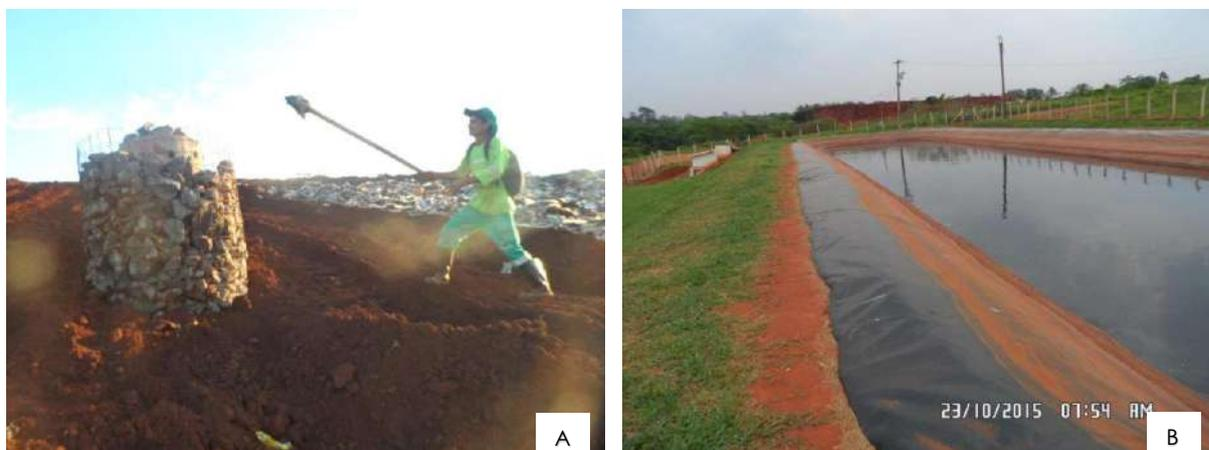
**Figura 54 - Aterro Sanitário Dom Antônio Barbosa II em Campo Grande. (A) Canalização de gases gerados; (B) Lagoa de retenção do chorume gerado.**
