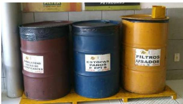
**Figura 82 - Dispositivos de acondicionamento de embalagens de óleos lubrificantes e outros resíduos contaminados em um posto de combustível.**
