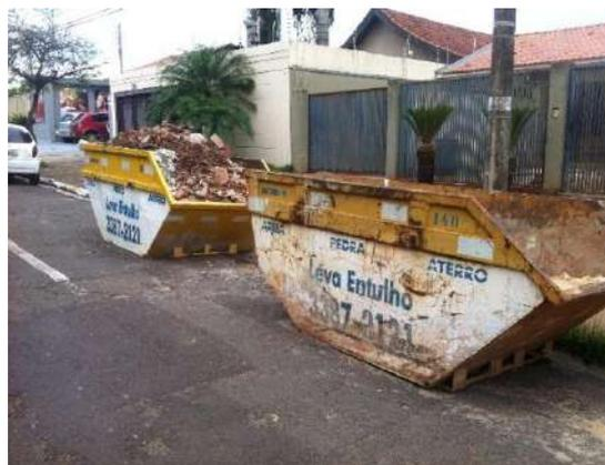
**Figura 69 - Caçambas para acondicionamento de RCC.**
