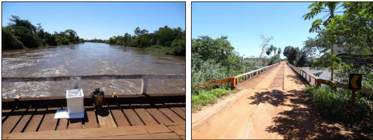
Figura 20 – Ponto de coleta localizado no Rio Dourados (DMTR_08_RD) e ponte próxima. Fonte: Deméter Engenharia Ltda., 2013.
